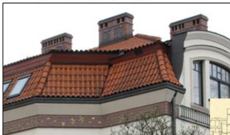
Krycie dachówką korytkową
